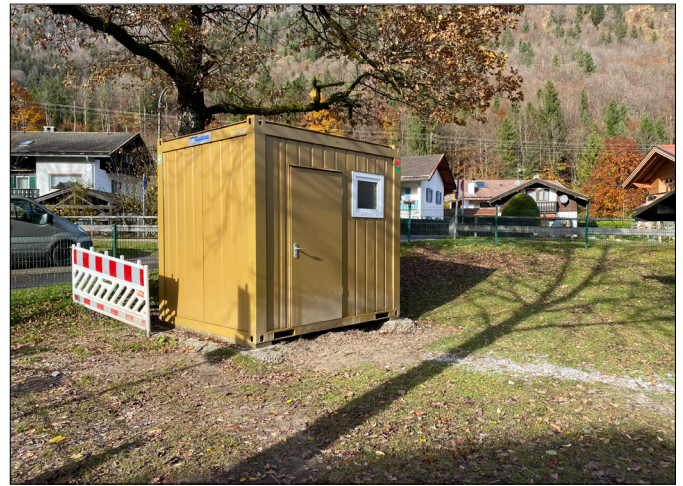
Das neue Toilettenhäuschen.
